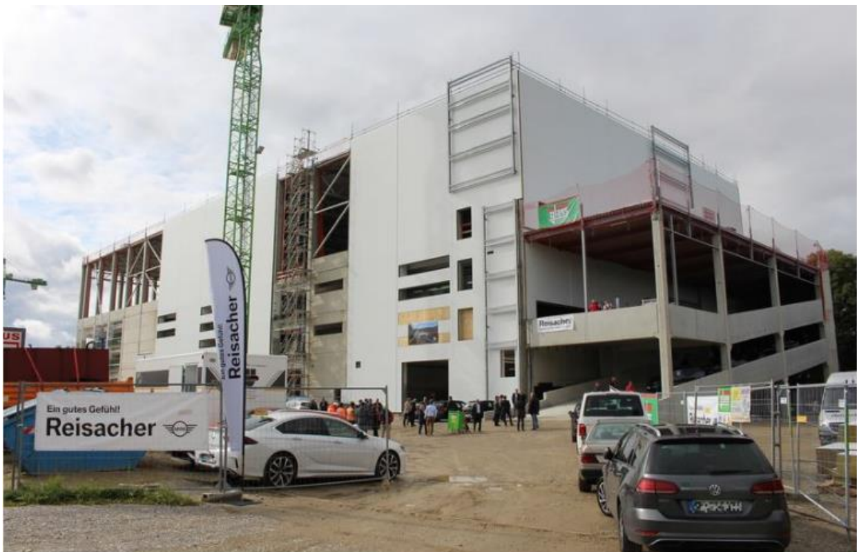
Die Baustelle zum Richtfest am 2. Oktober. Foto: Iris Zeilinhofer/B4B WIRTSCHAFTSLEBEN SCHWABEN
