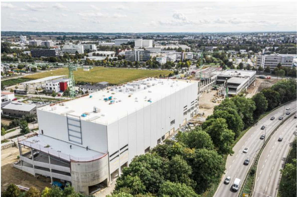
Die Baustelle Ende September von oben. Foto: Autohaus Reisacher
